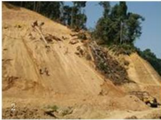
Hình 2. Sạt lở quy mô lớn trên đường Hồ Chí Minh tại đèo A Roằng, Thừa Thiên Huế.
