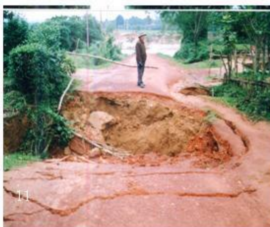
Hình 10, 11. Sụt đất do hoạt động karst tại thôn Tân Hiệp, xã Cam Tuyền, Quảng Trị.
