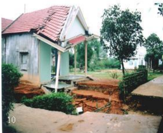
Hình 10, 11. Sụt đất do hoạt động karst tại thôn Tân Hiệp, xã Cam Tuyền, Quảng Trị.
