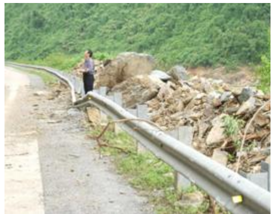
Hình 8. Đổ đá tại Km 114 T +385 đường HCM (03/10/2009).
