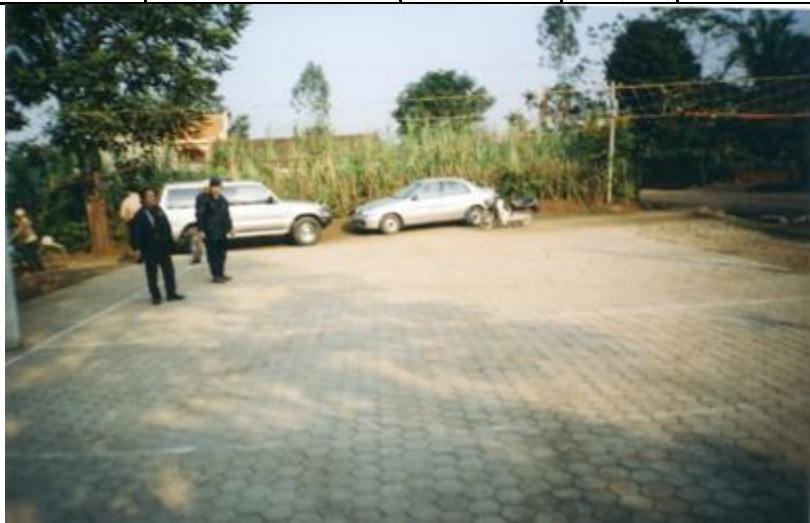
Hình 1. Sân nhà văn hóa Long Hạ, xã Nghĩa Mỹ, Nghĩa Đàn, Nghệ An được lát bằng gạch không nung làm bằng puzzolan.
