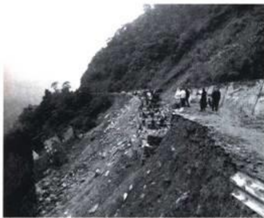
Ảnh 5. Khối trượt km 81 QL8 làm toàn bộ nền đường cùng công trình phụ trợ bị sạt xuống phía dưới (Ảnh: Nguyễn Văn Phổ, 10/2013).
