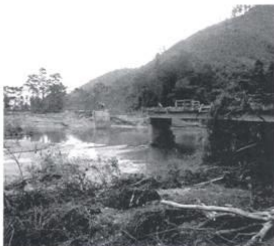
Ảnh 8: Lũ quét dâng cao 6 m cuốn trôi cầu Đà Đón xã Sơn Kim 2, huyện Hương Sơn (Ảnh: Nguyễn Văn Phổ, 10/2013).
