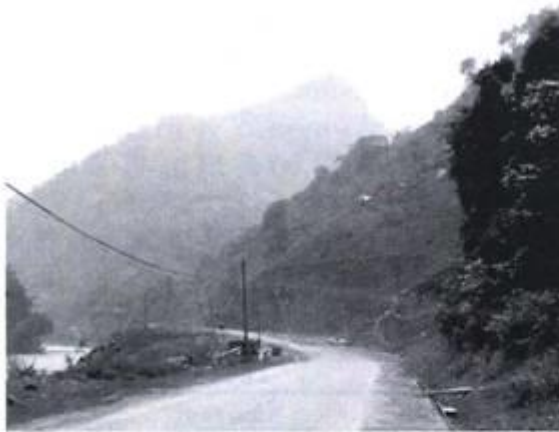
Ảnh 1. Khối trượt Tàn Xà hoạt động, đẩy nền đường QL7 di chuyển về phía sông Cả, uốn cong đường (Ảnh: Nguyễn Tiến Thành, 6/2013).
