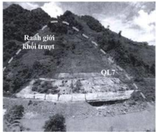
Ảnh 2. Toàn cảnh khối trượt Sốp Tọc. QL7 bị uốn cong, dịch chuyển về phía sông Cả (Ảnh: Nguyễn Tiến Thành, 6/2013).
