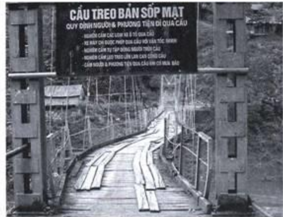
Ảnh 4. Khối trượt Sốp Mạt hoạt động làm cầu treo Sốp Mạt bị uốn cong hình chữ "S" (Ảnh: Nguyễn Tiến Thành, 6/2013).
