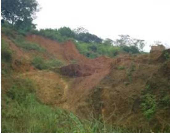
Hình 6. Trượt đất, xói mòn xẻ rãnh và xói mòn bề mặt trên đất vô phong hóa dày trên đá gốc bazan thuộc hệ tầng Viên Nam tại thôn Cao Sơn, xã Tiên Phương (h. Chương Mỹ). Ảnh Phan Xuân Thắng, 2010.
