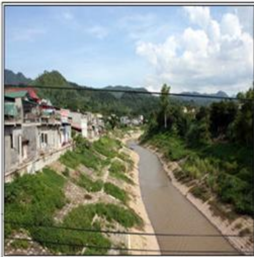
Hình 8. Cửa suối Đen bị sạt lở nhiều lần và đã được kè đá (năm dọc đứt gãy á kính tuyến sườn đông thị xã Hòa Bình).
