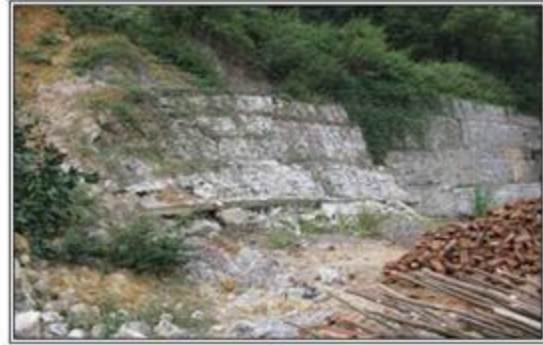
Hình 13. Vách taluy kê nhà dân đã kê đá và bê tông (năm dọc đứt gãy á kinh tuyến sườn tây thị xã Hòa Bình) lại tiếp tục nứt vỡ năm 2011.
