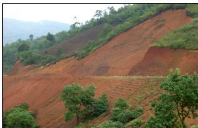
Hình 3. Trượt lở đất tại Km 21+200 trên tuyến đường Mèo Vạc đi Niệm Sơn.
