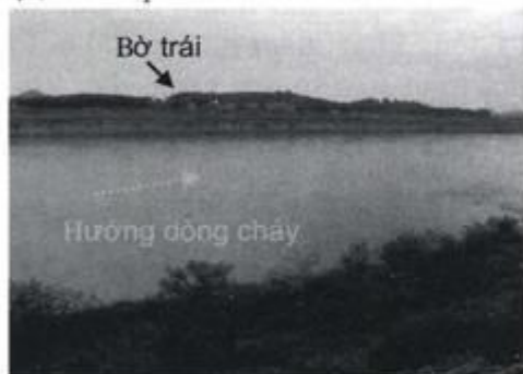
Ảnh 1. Trượt lở bờ sông dọc theo ĐG, dài 3 km (bờ trái sông Lô xã Hữu Độ) (Nguồn: Bùi Văn Thơm, 2013)
