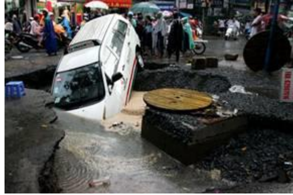
Hình 2. Đất xung quanh sụt lở rất nhanh khiến đầu chiếc xe taxi mỗi lúc một lún sâu xuống hố nước, ngày 14/9/2010 trên đường Lê Văn Sỹ.
