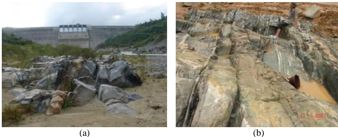
Hình 3. Đập thủy điện Sông Tranh 2 (a) và đặc điểm địa chất nền móng (b) [12]. (Nguồn: Công ty Khảo sát - Thiết kế Điện 1)
