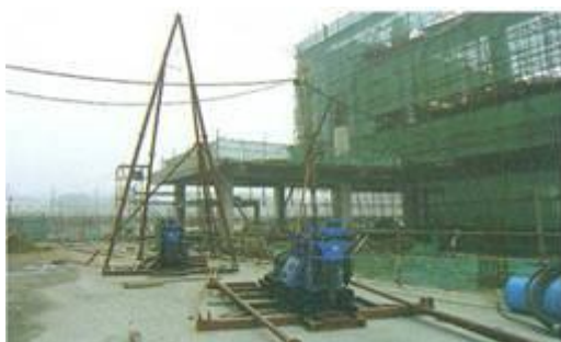
Ảnh 3. Tháp khoan bốn chân gắn liền với giá máy để tăng cường ổn định cho máy khoan trong khi kéo thả cần khoan của nhà sản xuất (Nguồn: Vũ Bá Muôn, 2012).
