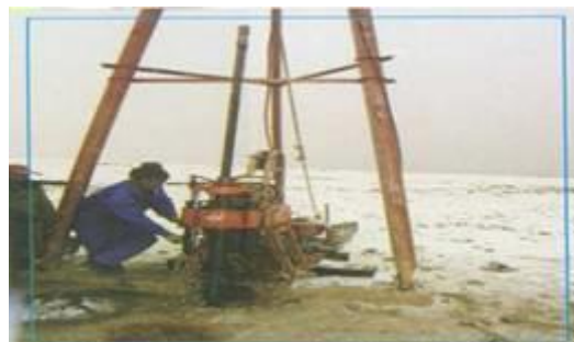
Ảnh 4. Tháp khoan ba chân gắn liền với giá máy để tăng cường ổn định cho máy khoan trong khi kéo thả cần khoan của đơn vị thi công (Nguồn: Vũ Bá Muôn, 2012).
