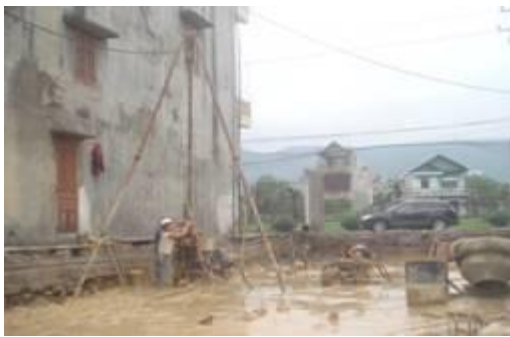
Ảnh 1. Tháp khoan ba chân và máy khoan XY-1 khoan địa chất công trình phục vụ xây dựng (Nguồn: Vũ Bá Muôn, 2012).
