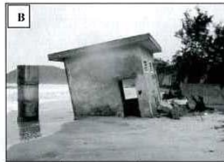
Ảnh 6. A) Di tích tháp Châm tại Mỹ Khánh bị chôn vùi và hiện nằm cách mặt đất khoảng 10 m và nằm dưới mực nước biển (xã Phú Diêm, huyện Phú Vang (Điểm lộ H14-15); B) Trạm bơm cấp nước ngọt tại xã Vĩnh Hải trước đây nằm sâu trong đất liền đang bị biển xâm thực và phá hủy.
