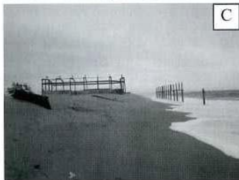
Ảnh 6. A) Điểm trượt lở trong đá granit phức hệ Đèo Cà bị đập vỡ và phong hóa mạnh tại TH 15-03; B) Điểm trượt lở trong đới biển dạng mạnh ở phía bắc Đèo Cà. Trượt lở diễn ra dọc đới đứt gãy cắt qua đá granit với các thể sót của đá trầm tích; C) Phần sót lại của nhà máy đóng tàu Vinashin ở phía bắc của Đà Nẵng. Biển xâm thực vào đất liền hàng trăm mét dẫn tới sự phá hủy nhà máy; D) Khu dân cư ở phía nam cửa Đà Nẵng bị sóng biển phá hủy TH 03-12.
